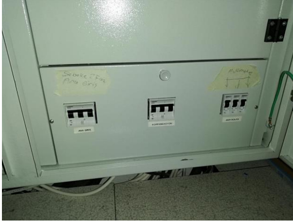
Resim 7 PANO İÇ KORUMA KAPAĞI (METAL IP2X)_02
