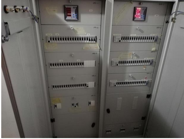
Resim 1 PANO İÇ KORUMA KAPAĞI (METAL IP2X)_01
